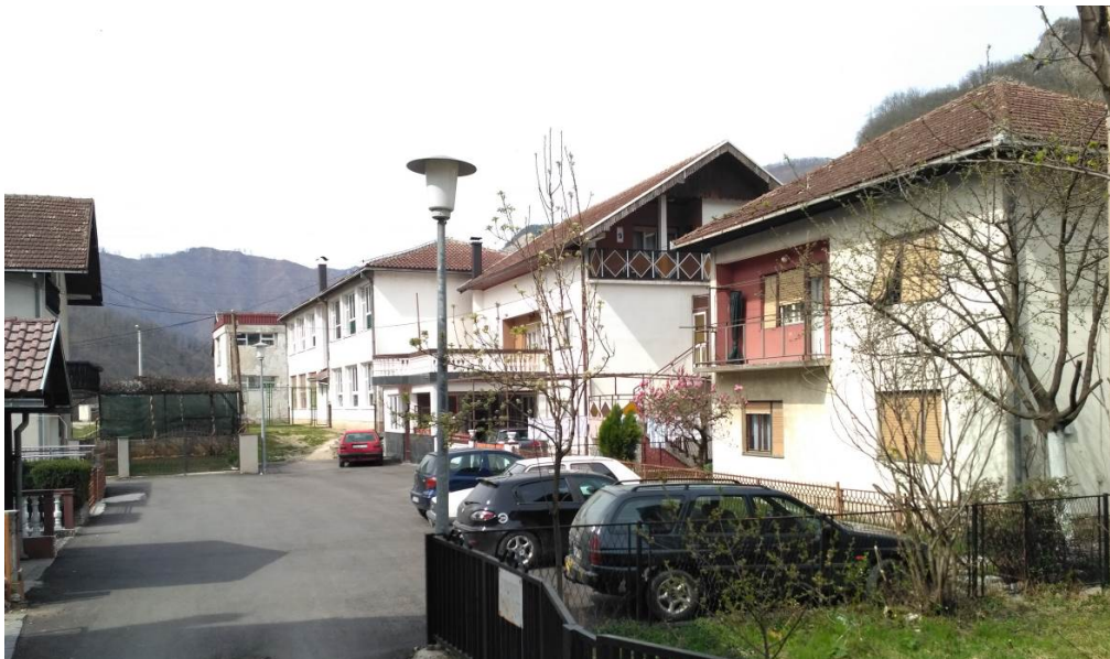
Slika 3: Postojeći stambeni objekti (izvor: Ecoplan)
